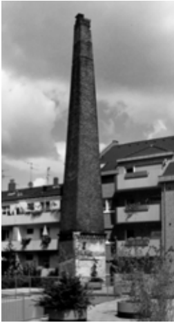
Oben: Letzer Rest der Firma Schiffmann: der Schornstein, 1995; Unten: das Fabrikgelände um 1900
